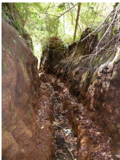
Erosión del camino
